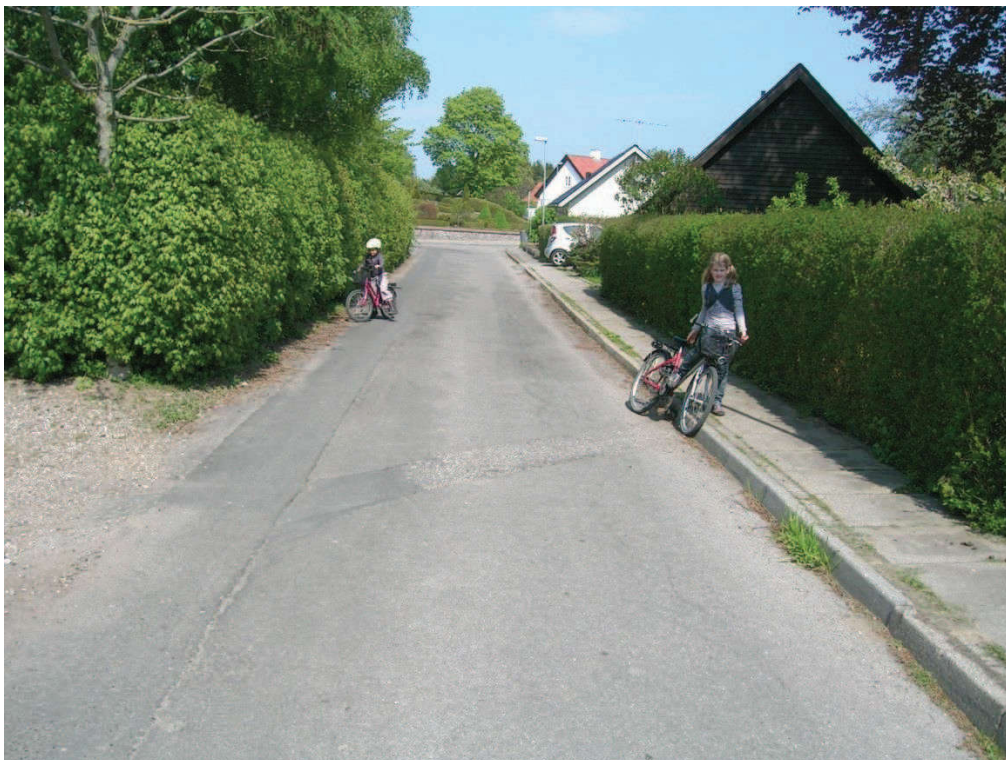
Eksempel 2. Trafikklasse T1 Restlevetid: 29 %
