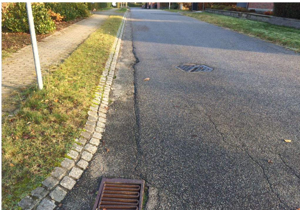
Foto 10: Rendereetablering efter kloakarbejder har sat sig og slår fra den resterende belægning, som er revnet og krakeleret (foto delomr. D2 ved tilslutning fra stamvej)
