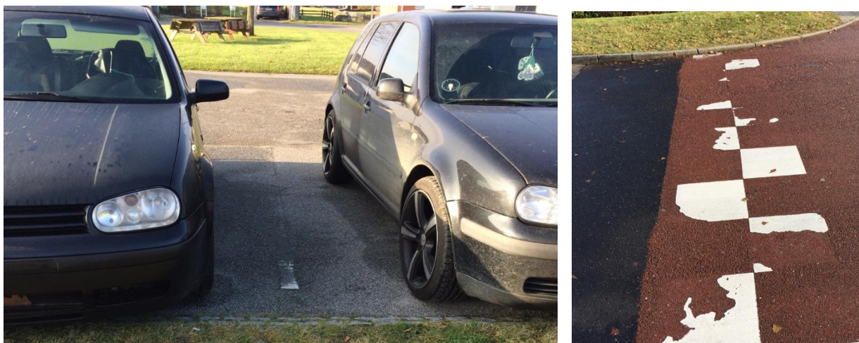
Foto 12: Generelt er trafikmarkeringerne nærmest ikke-eksisterende (P-arealer, hjøjtænder, bump-markeringer m.v.)
