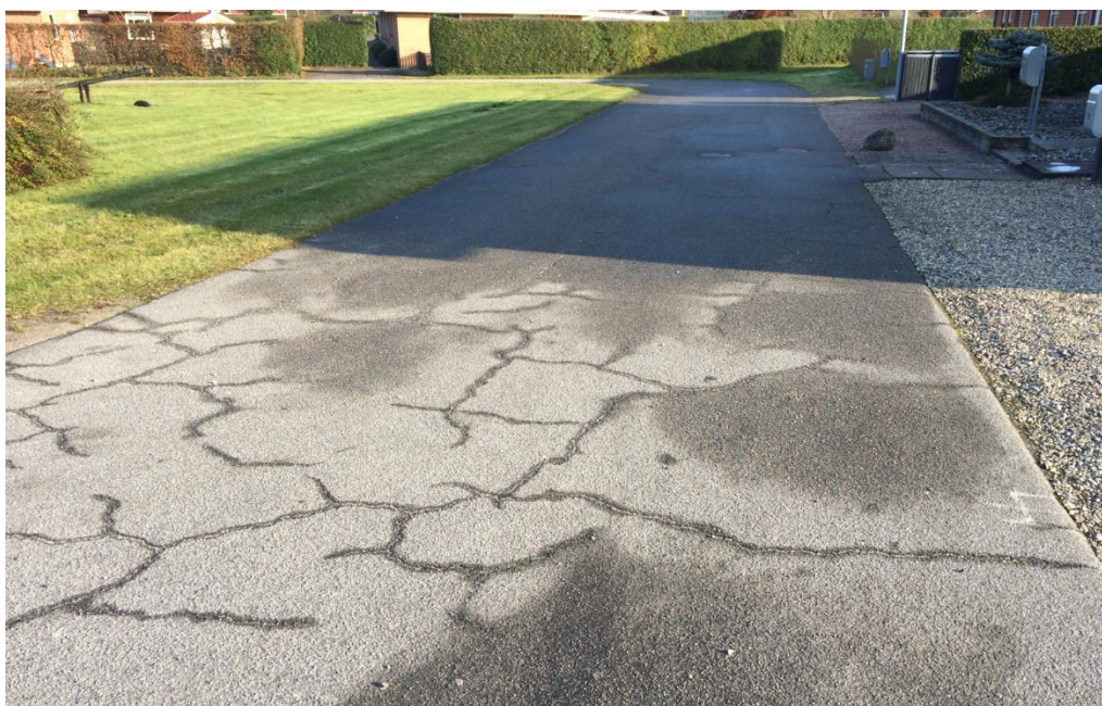
Foto 5: De steder hvor solen havde stået længe nok på til at give optørring af vejoverfladen trådte krakeleringsevnerne tydeligere frem. (foto: delomr. A5)
